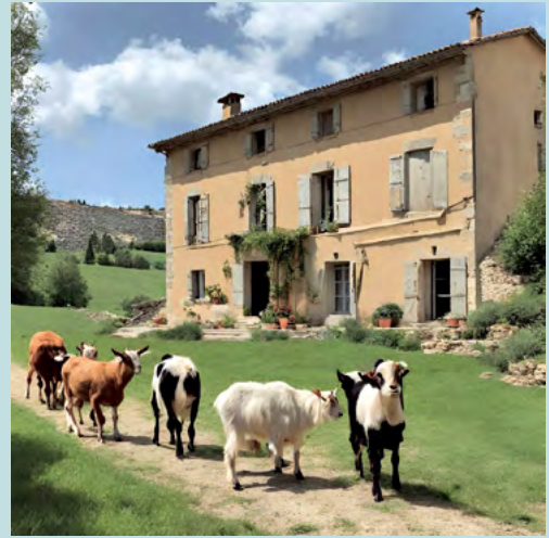
L'Oasienne, une ancienne ferme entièrement rénovée de 500 m 2 sur 3 niveaux
